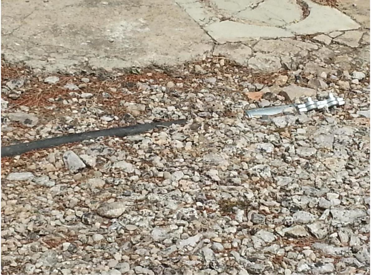
**TUBERÍA VISTA EN SUPERFICIE CON UNA REPARACIÓN METÁLICA EFECTUADA.**
