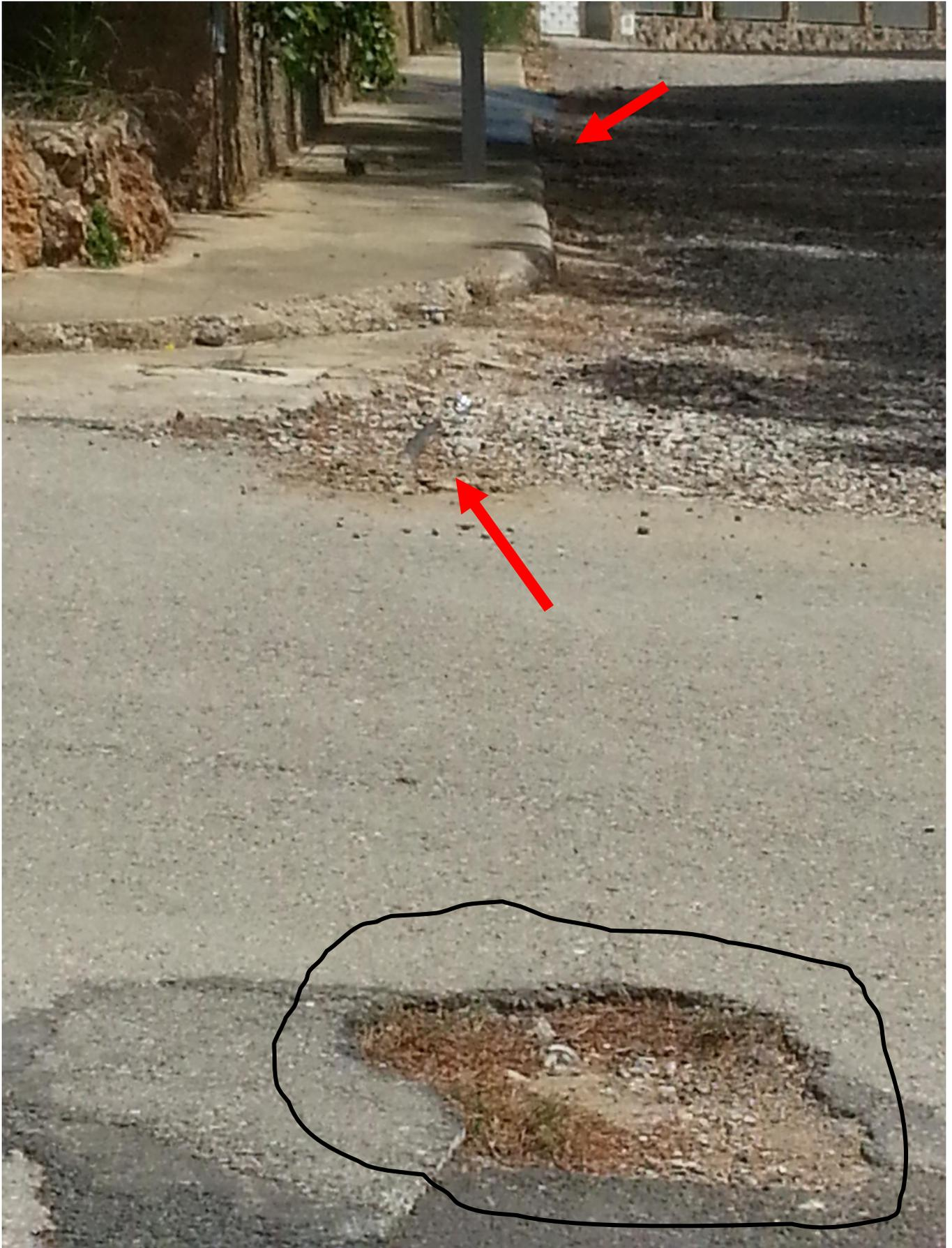
**Estado del Asfaltado después de la reparación de una fuga.**
